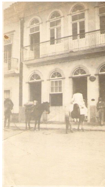
Figura 5: Fachada em 1921 Fonte: Guimarães (1921)
