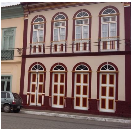
Figura 6: Fachada em 2018 Fonte: Jaccoud (2018)
