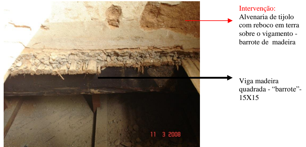
Figura 18: Parede de tijolo de barro cozido sobre o maciço - laje de Jussara, Juçara e/ou Içara (2008) Fonte: Jaccoud (2008)
