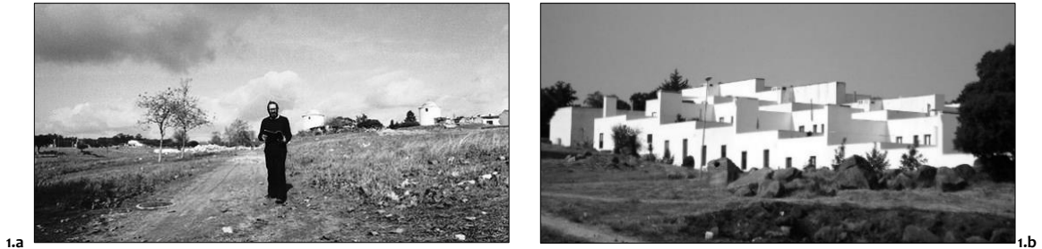
Figura 1.a: Álvaro Siza em Évora, no local de implantação do conjunto Quinta da Malagueira (1977). Figura 1.b: Vista parcial da mesma obra, em 2017: preservação das características do projeto, passados 40 anos. Fontes: Figura 1.a: ArchDaily (2017); Figura 1.b: Prancheta de Arquiteto (2015)
