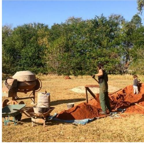
Figuras 39 e 40: Juntos, separando e preparando a terra para erguer a parede de taipa de pilão.
