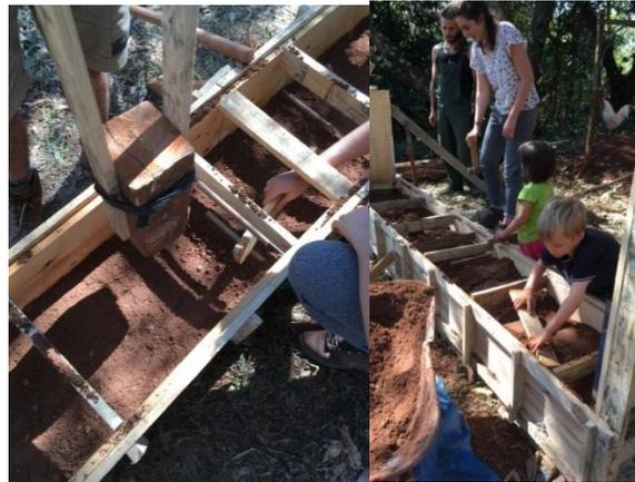
Figuras 41 e 42: Apiloando a terra e erguendo, num desenho lógico, a parede de taipa de pilão.
