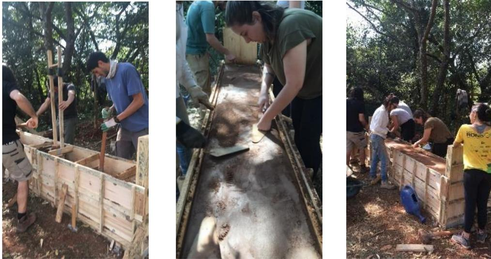
Figuras 48,49 e 50: Pouco a pouco, com várias mãos, a parede de taipa de pilão vai se formando.
