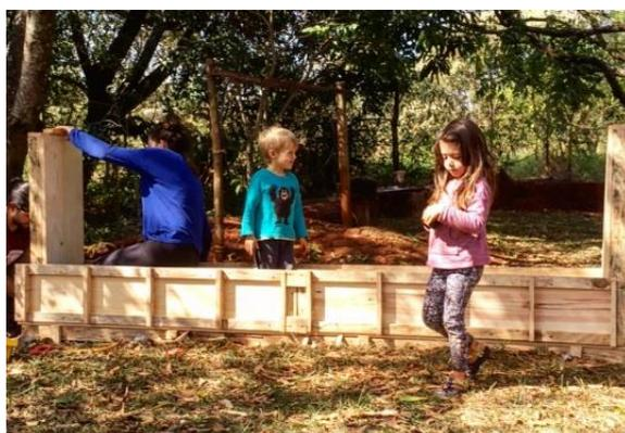
Figura 27: Forma de madeira preparada para receber o barro e formar a parede de taipa de pilão.
