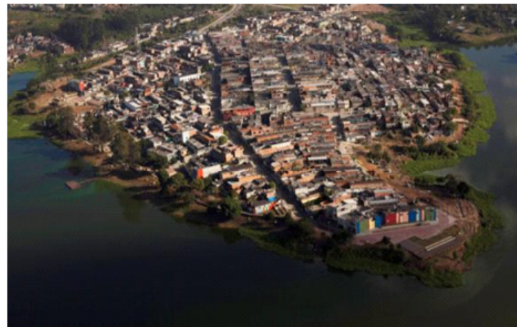
Figura 7.27 - Trecho 1 – Parque dos Lagos – Vista do parque em implantação - Projeto Cores na Billings.
