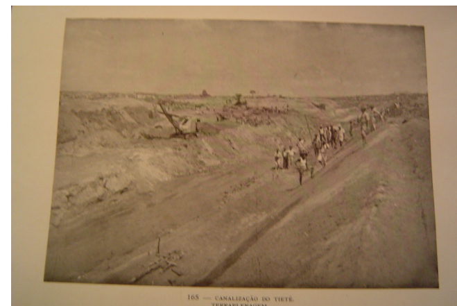
Figura 3.7 - Obras de Canalização do Tietê
