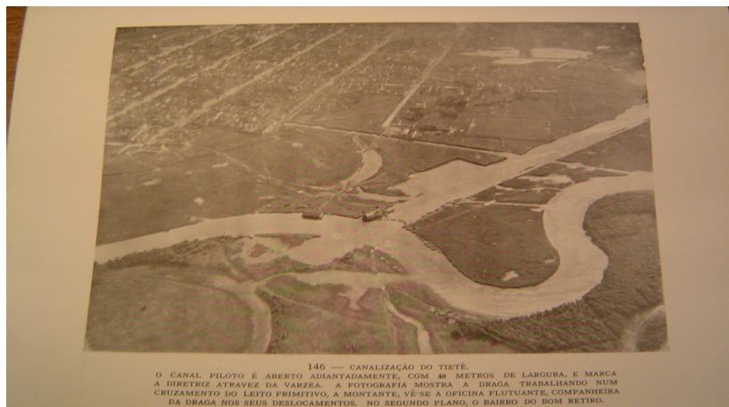
Figura 3.6 - Obras de Canalização do Tietê
