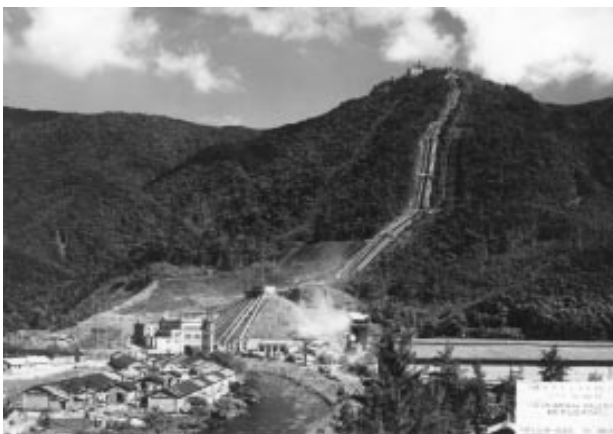
Figura 3.10 - Construção da UHE Henry Borden em Cubatão, sem data. Fonte: ISA, Seminário Billings 2000. ISA, 2002.
