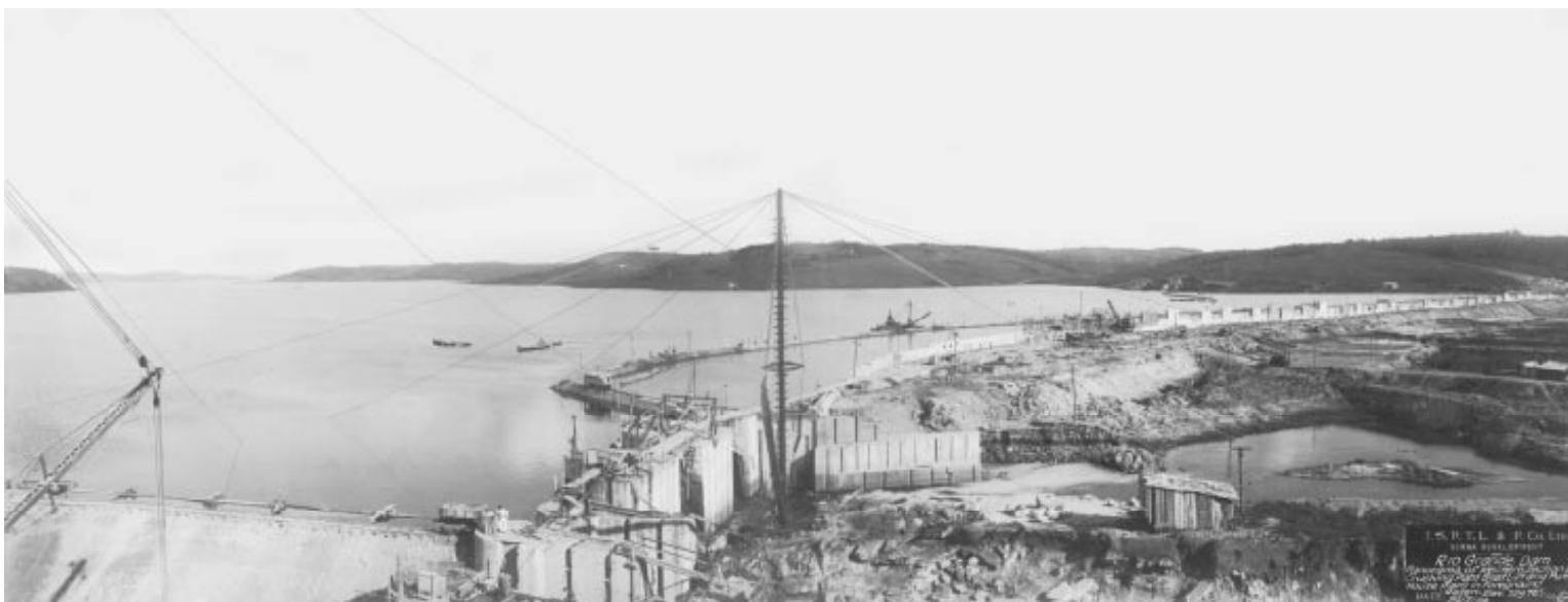
Figura 3.12 - Construção da Barragem de Pedreira no curso do Rio Grande ou Jurubatuba, 1928. Fonte: ISA, Seminário Billings 2000. ISA, 2002.
