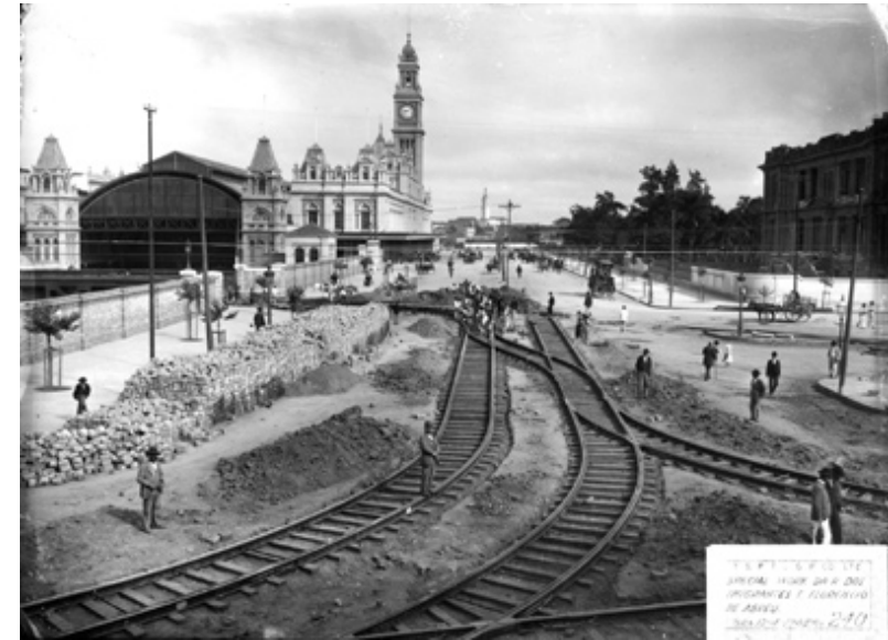
Figura 3.3 - Colocação de trilhos na estação da Luz – 1902.
