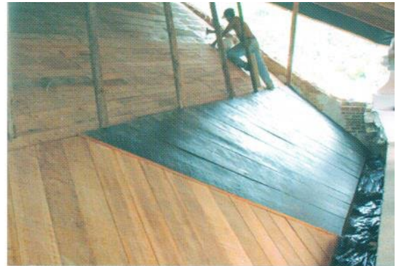
REFORÇO ESTRUTURAL DO TELHADO
