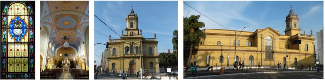
Figura 6: a) Vitral restaurado; nave, b) fachada frontal e c) fachada lateral direita restauradas. Fonte: Autoras, 2019.
