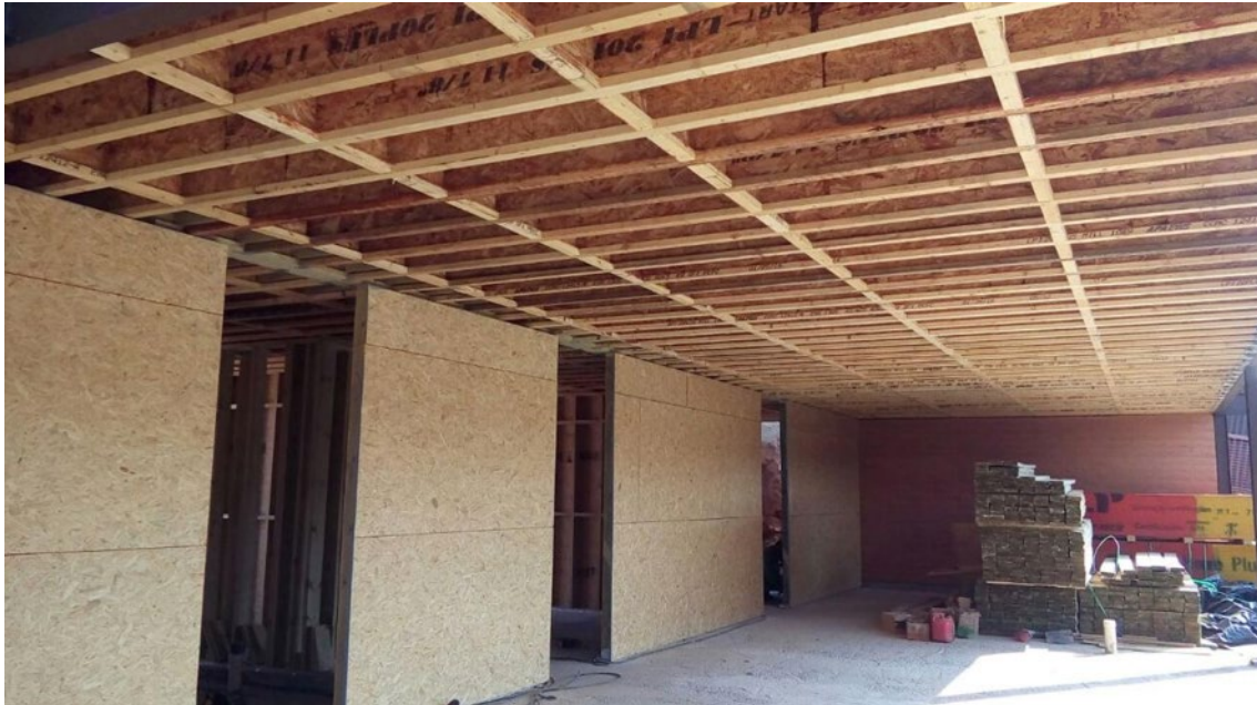
Figura 4: Paredes e laje em woodframe Casa Terra Fonte: Acervo Pessoal
