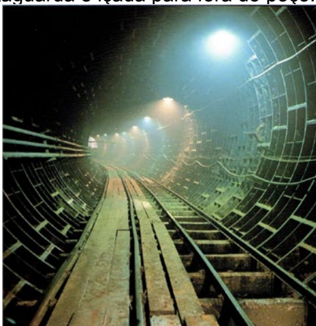
Imagem 2: Túnel por processo construtivo shield, com destaque e corte dos anéis metálicos. Fonte: Revista Promon Notícias, volume 16, 1989, encontrada em material disponibilizado pelo escritório JBMC. Fonte do corte dos anéis metálicos: Livro HMD (1968).
