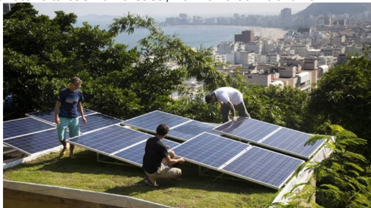
Figura 4: Instalação de painéis fotovoltaicos na cobertura de uma casa, Morro da Babilônia, R.J Fonte: O Globo – Rio
