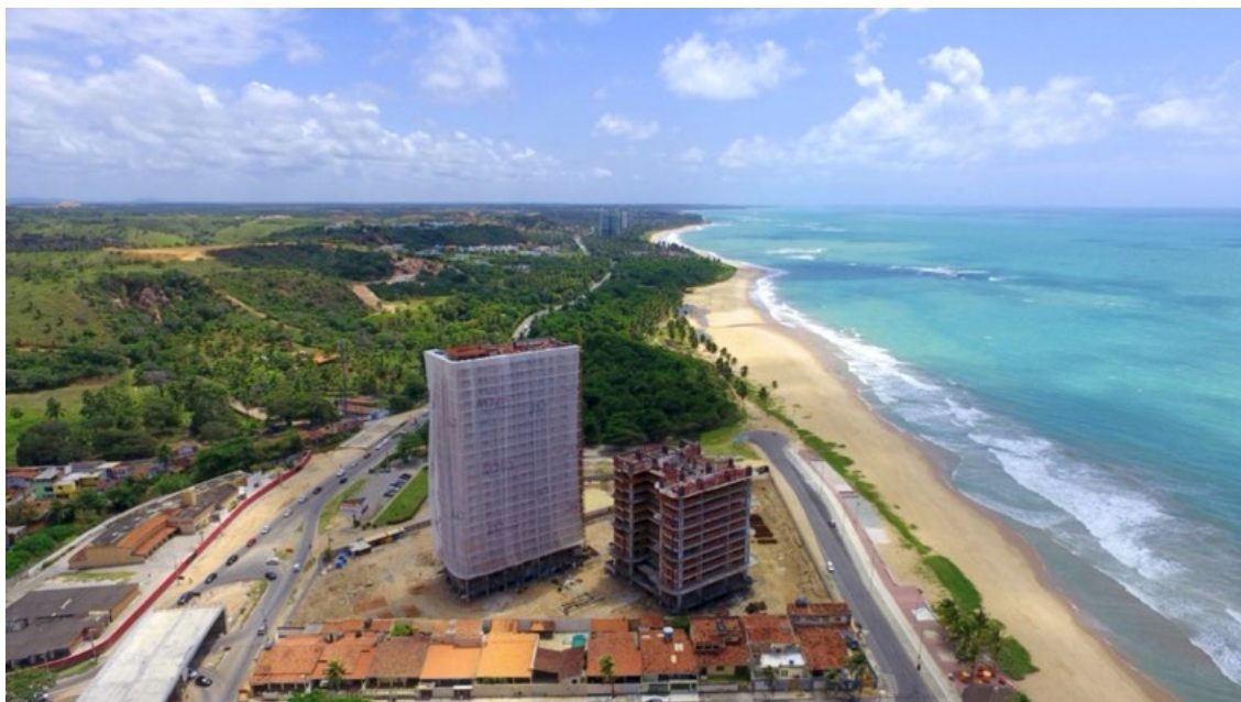
Figura 4: Fotografia aérea da construção do condomínio Evolution Sea Park Fonte: Arquivo pessoal
