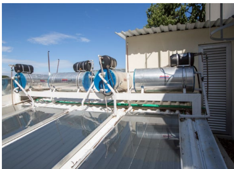
Figura 3: Cobertura do edifício HAB 2, morro da Babilônia, R.J Fonte: Escritório Arquitraço.
