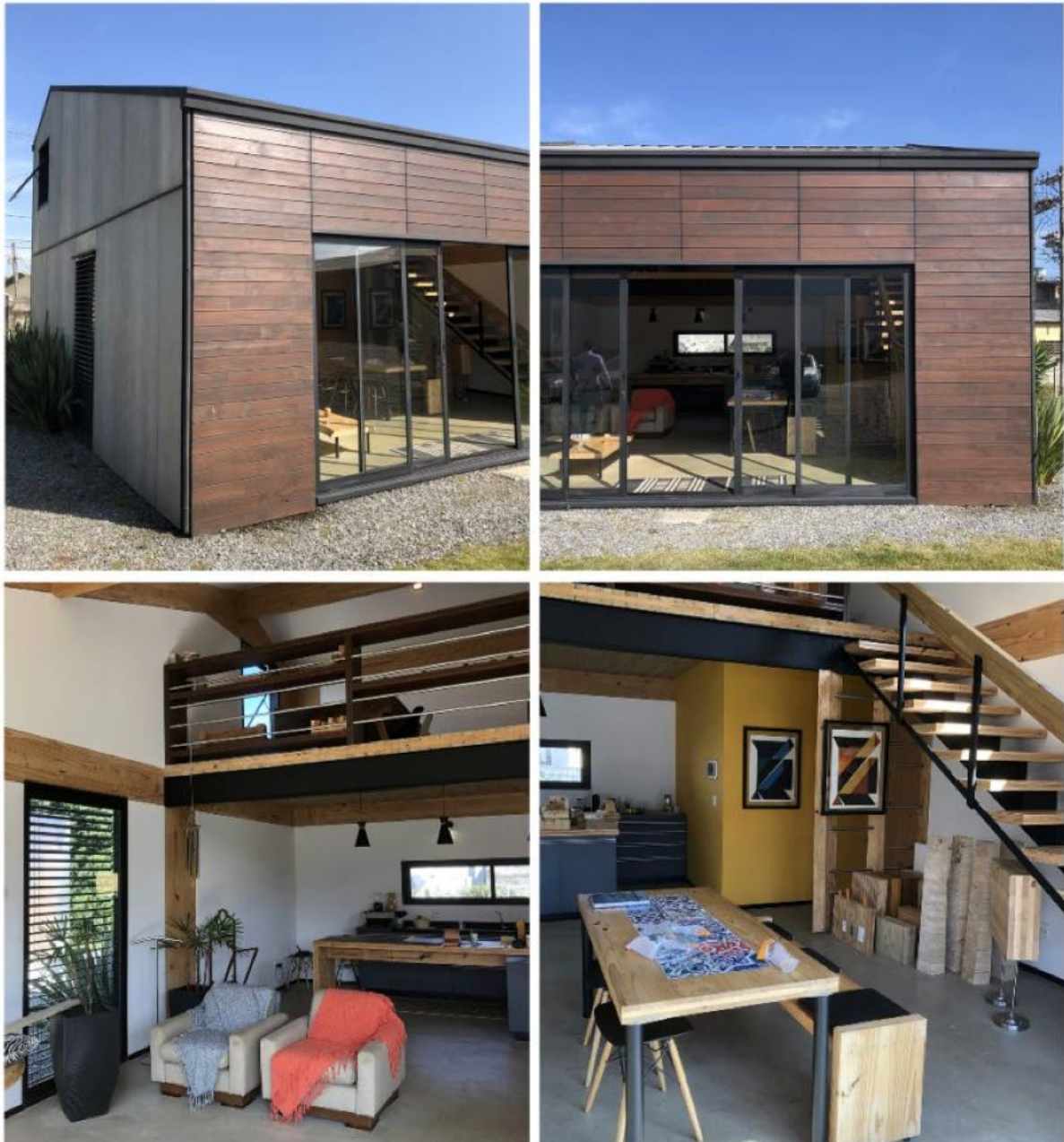
Figura 5: Exemplo de residência pré-fabricada em Madeira Laminada Colada (CLT). Fonte: Foto do Autor na fábrica da CROSSLAM
