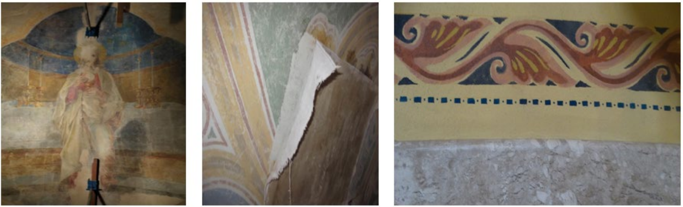
Figura 4: a) Pintura antes do restauro; b) técnica do “strappo” para retirar as imagens e c) Faixa com revestimento de mármore e pintura restaurada acima.
