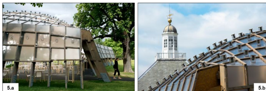
Figura 5.a: Revestimento translúcido acoplado diretamente sobre a estrutura lamelar de madeira, instalado a 1,3m da base.
