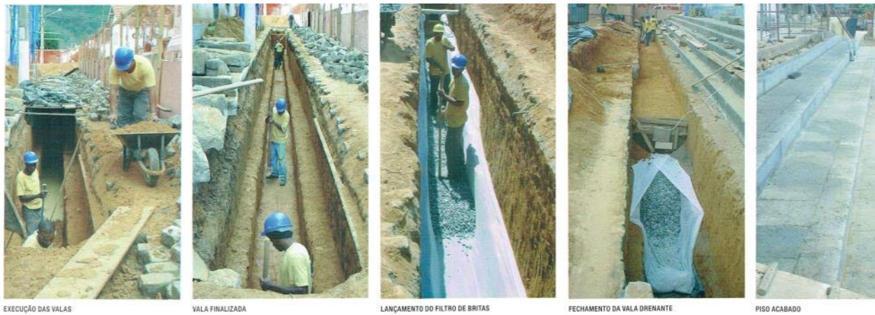
Figura 9 - Execução das valas drenantes Fonte: CORRÊA LYRA, 2006, p.72
