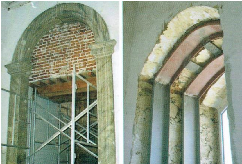
Figura 8 - Fechamento provisório dos arcos e reforço estrutural Fonte: CORRÊA LYRA, 2006, p.79
