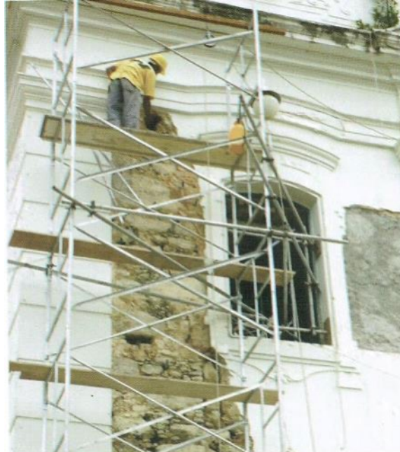
Figura 6 - Costura das fissuras Fonte: CORRÊA LYRA, 2006, p.79
