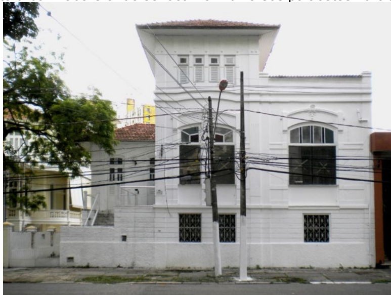
Fig.1: Palacete Orlando Lima. Em primeiro plano, porão habitável e janelas do primeiro pavimento. Ao fundo, escada de acesso ao setor social.
