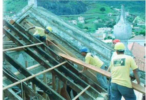
SUBSTITUIÇÃO DE CAIBROS
