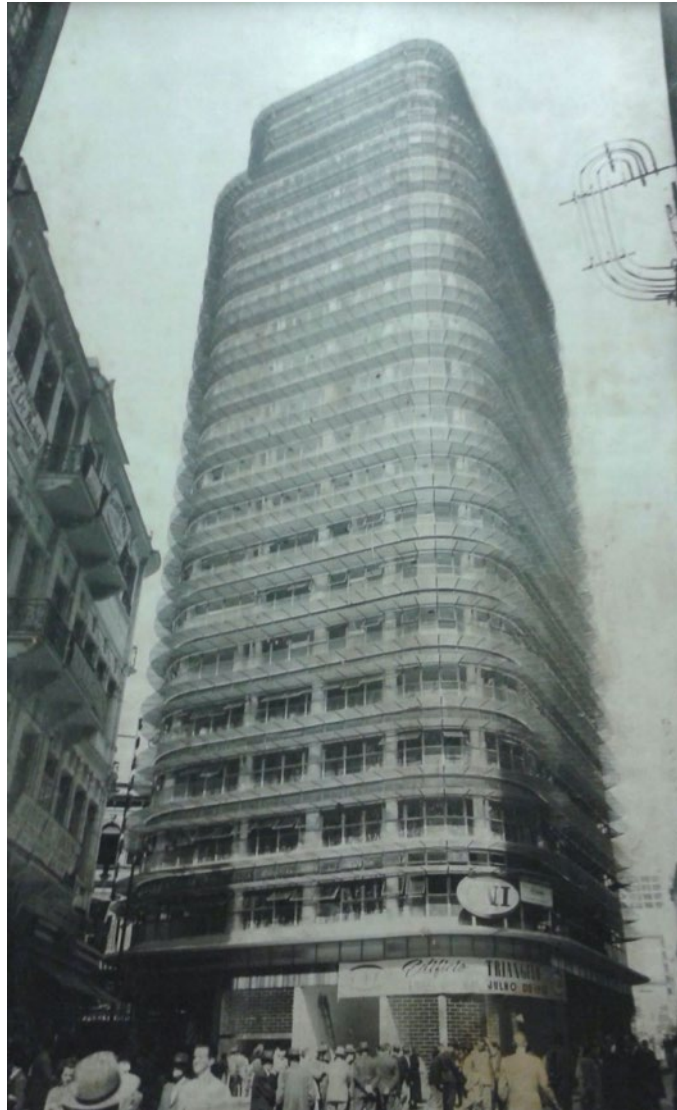
Figura 2: Edifício Triângulo, 1952, Oscar Niemeyer e Carlos Lemos Fonte: Biblioteca FAUUSP
