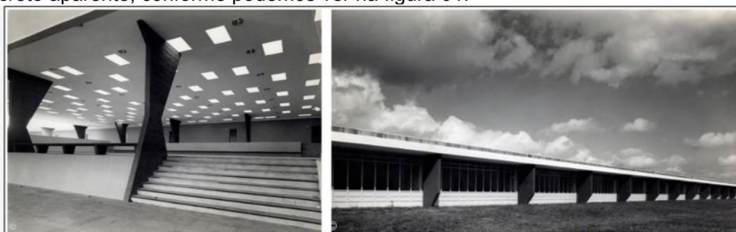
Figura 1: Ginásio Estadual de Guarulhos Fonte: Acervo Vilanova Artigas - Fotografia José Moscardi
