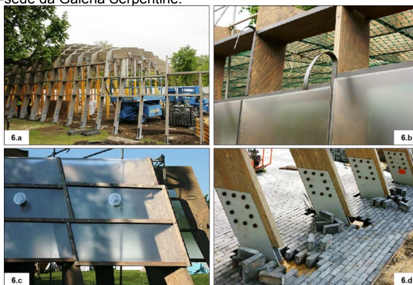
Figura 6.a: Fase de construção do pavilhão, com destaque para os vínculos metálicos dispostos entre a fundação e a estrutura. Figura 6.b: Fita flexível à base de PVC, usada para assentamento dos painéis de policarbonato. Figura 6.c: Ripas em madeira, para acabamento do revestimento translúcido. Figura 6.d: Piso intertravado de concreto, adotado no interior da obra.
