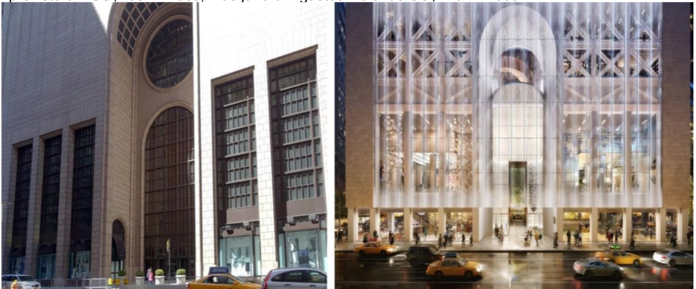
Fig.3. Imagens comparativas entre a fachada original e a proposta de alteração realizada pelo escritório Snohetta em 2017. Fonte: https://www.designboom.com/architecture/550-madison-avenue-snohetta-midtown-new-york-10-30-2017/
