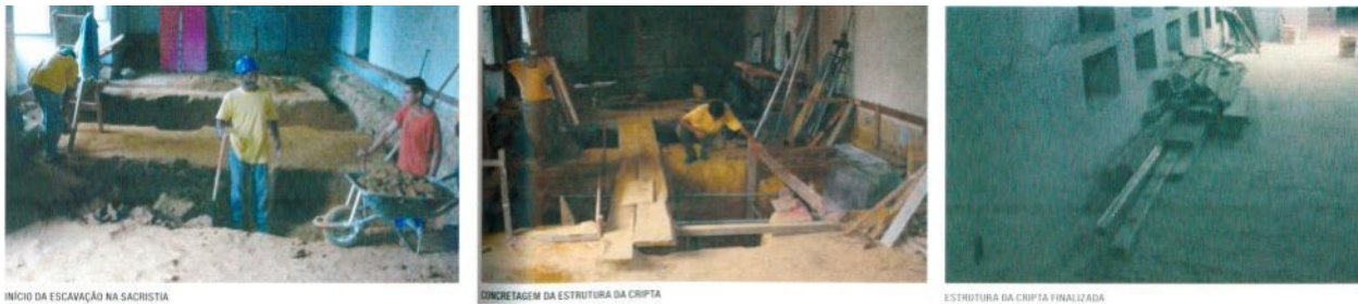
Figura 12 - Escavação para criação da cripta Fonte: CORRÊA LYRA, 2006, p.71
