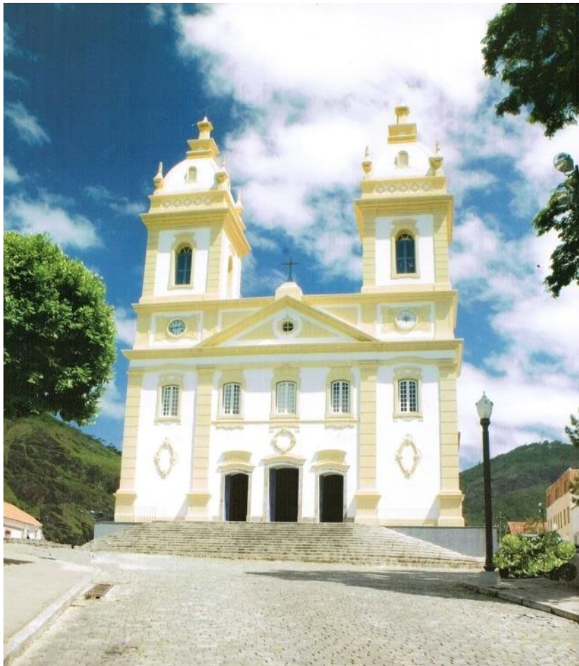
Figura 1 - Fachada frontal da Catedral de Valença Fonte: CORRÊA LYRA, 2006, p.2
