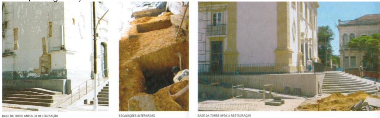
Figura 7 - Reforço do solo na região das torres Fonte: CORRÊA LYRA, 2006, p.74
