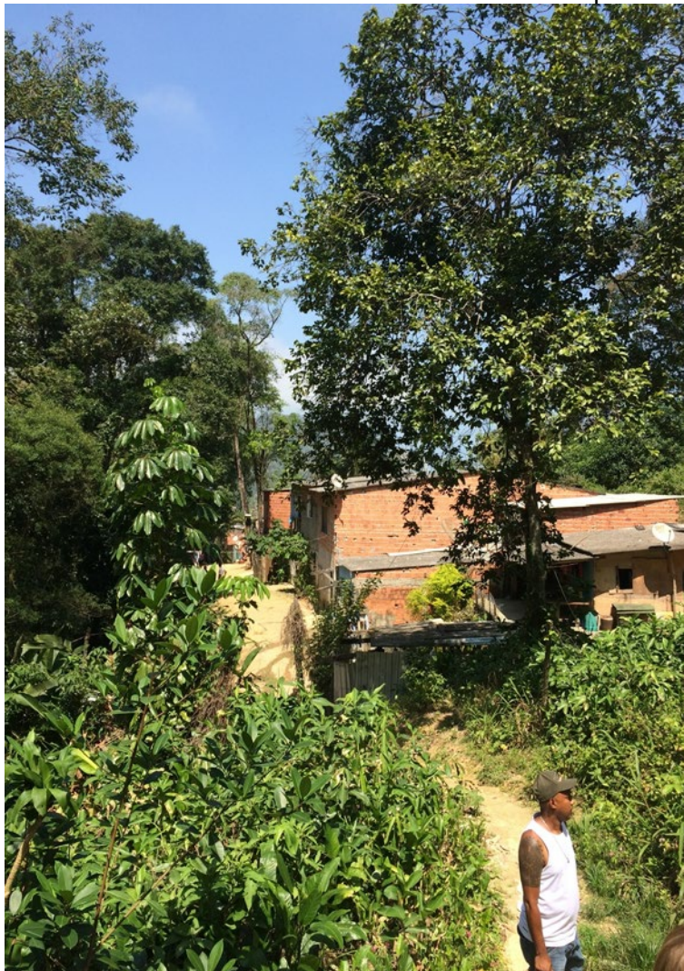
Figura 4: Residência em área de risco em São Sebastião Fonte: Acervo próprio, 2015
