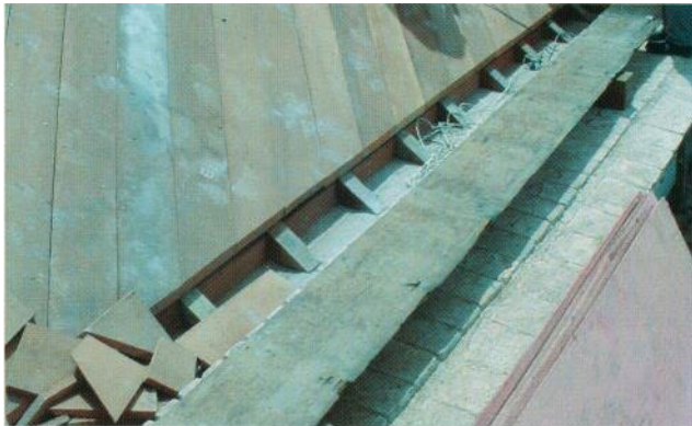
SUBSTITUIÇÃO DE FRECHAL
