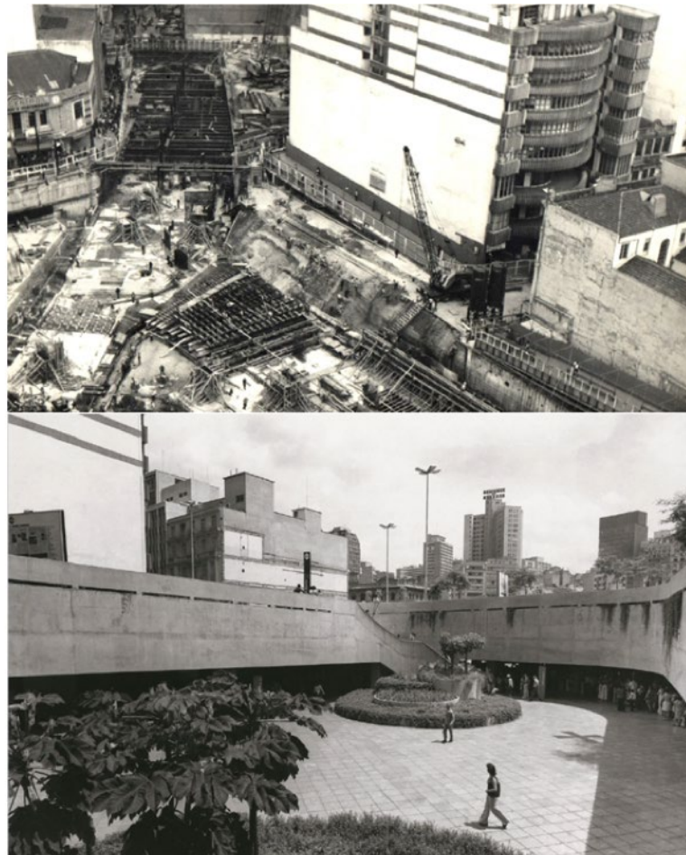
Imagem 5: Estação São Bento, obra e construída. Fontes: Acervo do escritório JBMC e livro Quarenta Anos de Prancheta, Marcello Fragelli.
