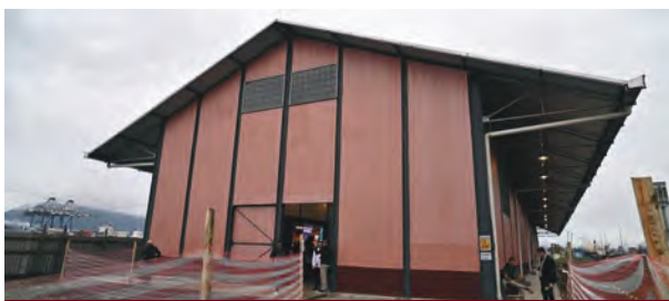
Edificação preserva as características originais do projeto de 1899.
